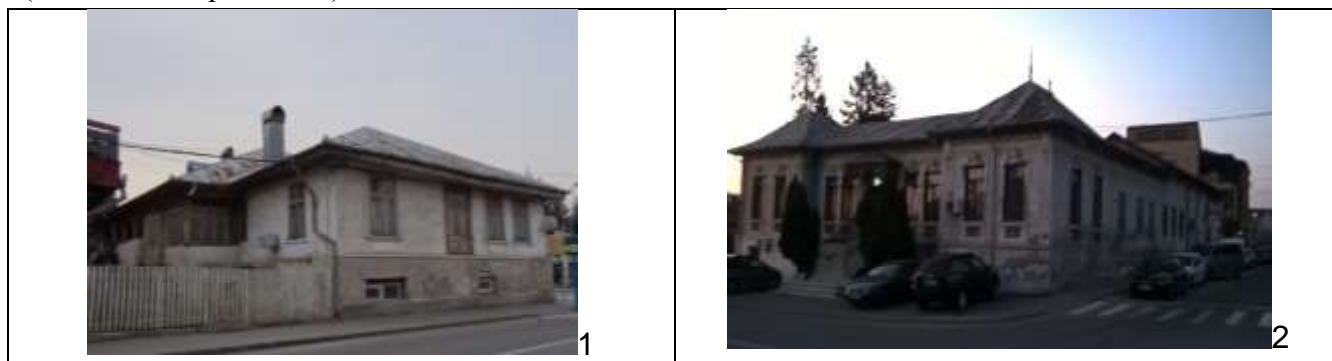
Foto. 1. Clădiri cu acoperiș și fațadă degradate (1- Str. Negru Vodă și 2 - Str. Sân Nicoară) (Sursa: arhivă personală)
